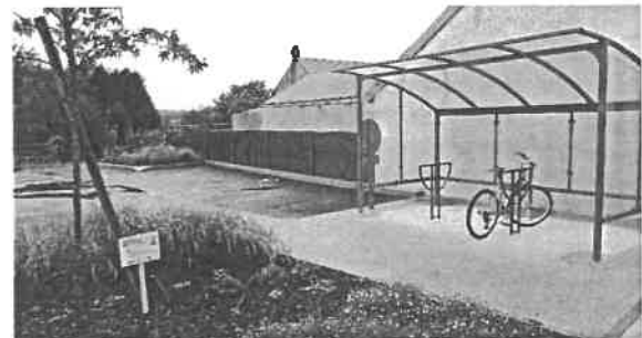
Aménagement pour cyclistes à Souffrès
