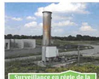
Surveillance en régle de la torche pour la récupération du biogaz des casiers fermés
