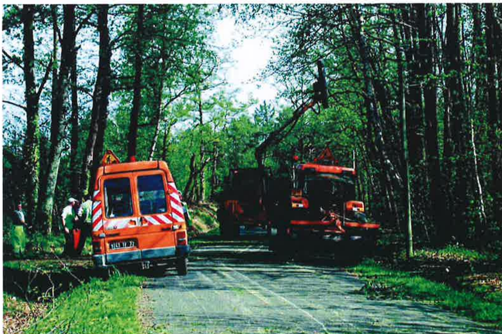
Des travaux d'élague sont nécessaires pour l'installation de la fibre.
