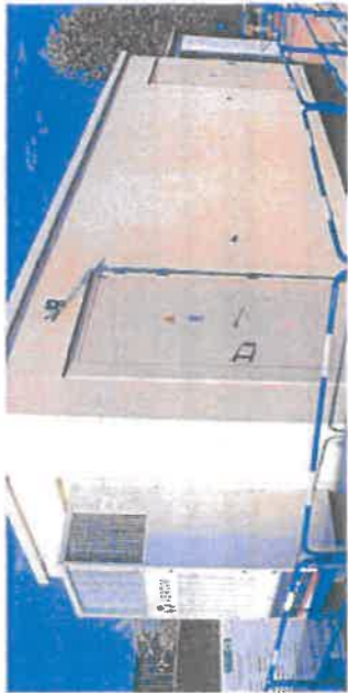
Ce grand caisson est un NRO, une sorte de gare de triage pour les flux d'information véhiculés sur la fibre optique.
