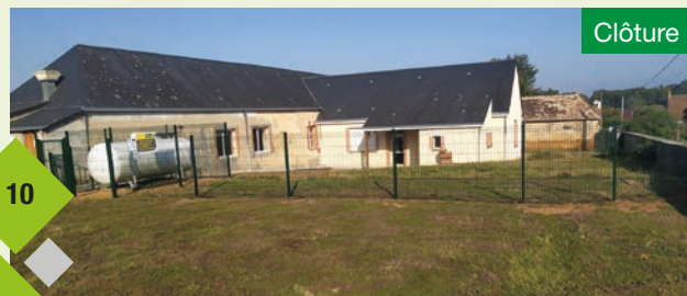
Après les travaux
