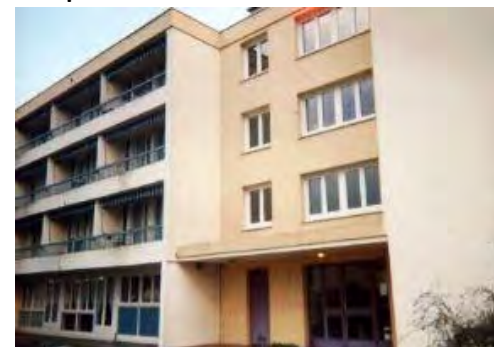
Foyer logement , logements CCAS Connerré 30 places
