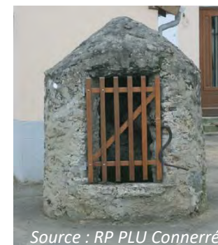
Puits à mitre, Connerré
