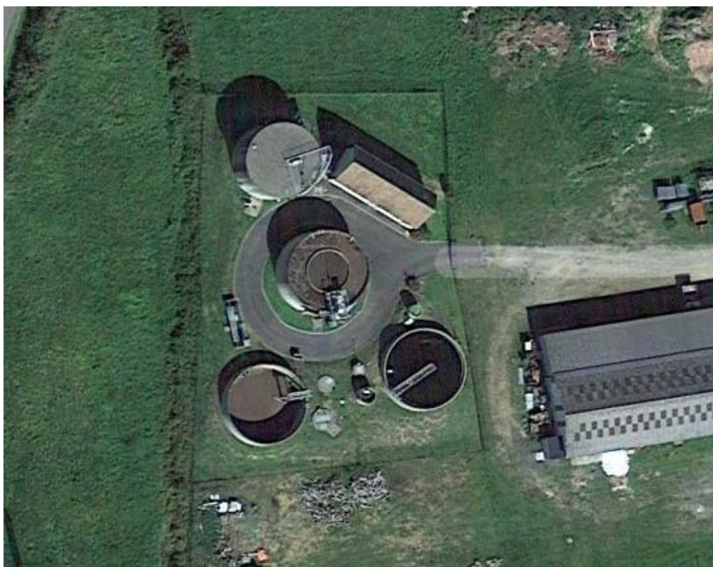
Vue aérienne de la station
