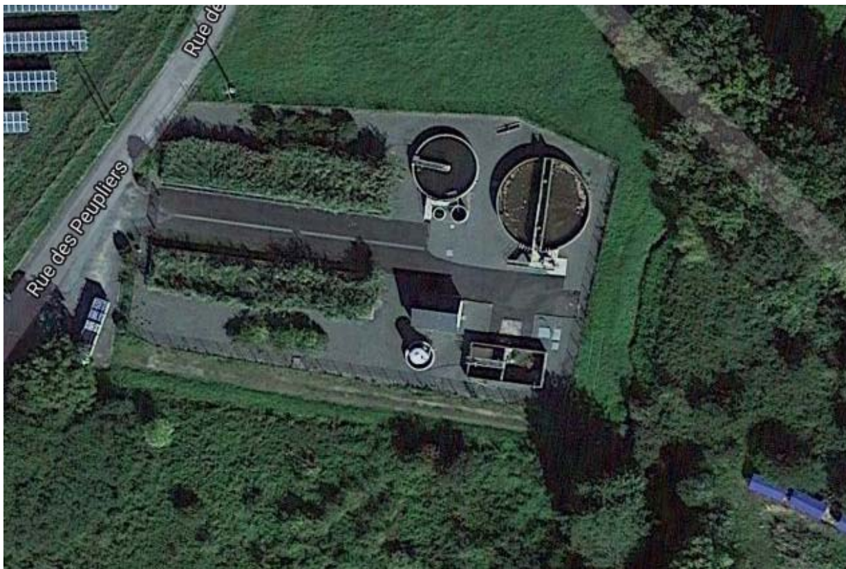
Vue aérienne de la station
