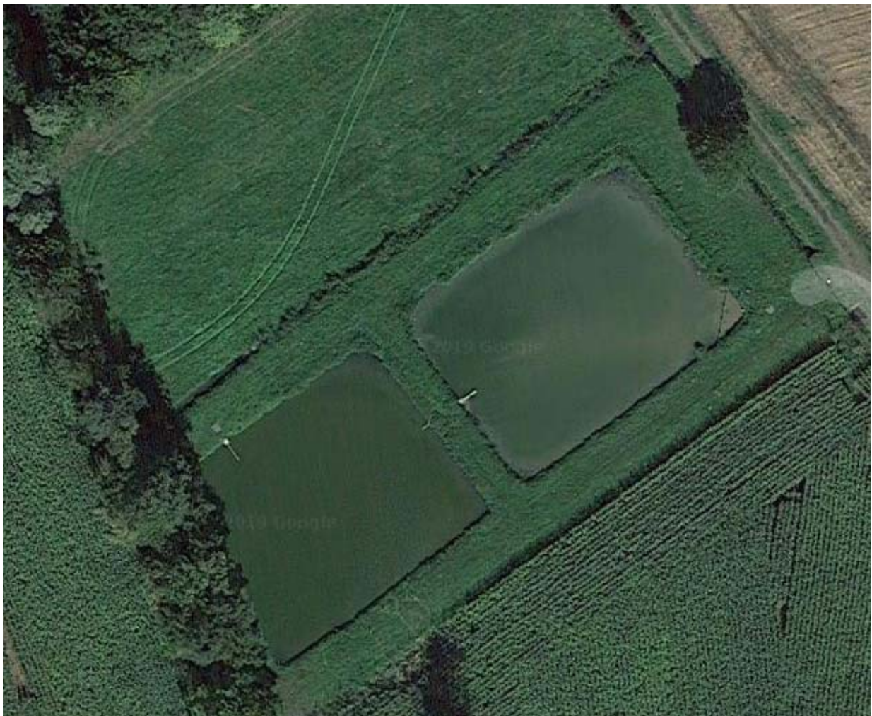
Vue aérienne de la station
