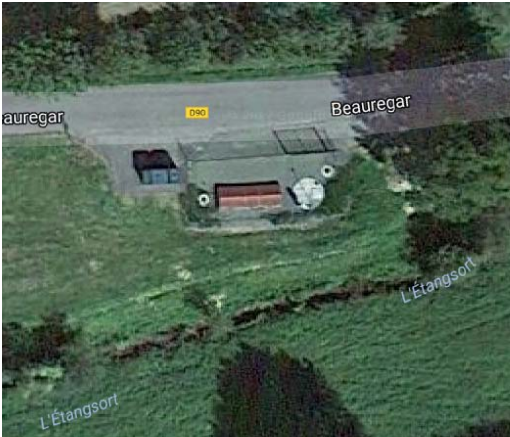
Vue aérienne de la station
