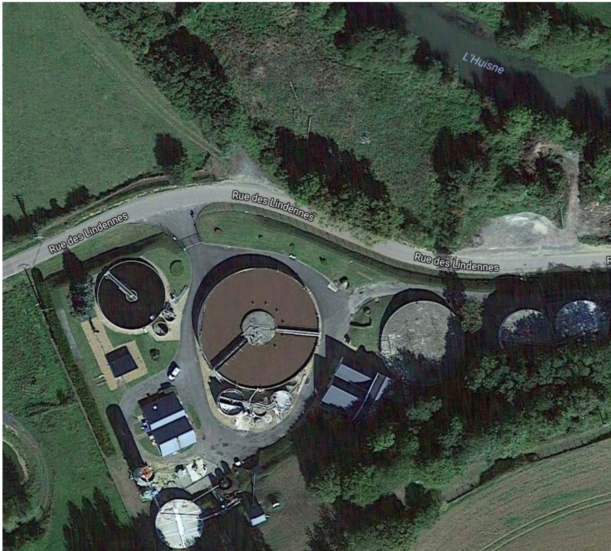
Vue aérienne de la station
