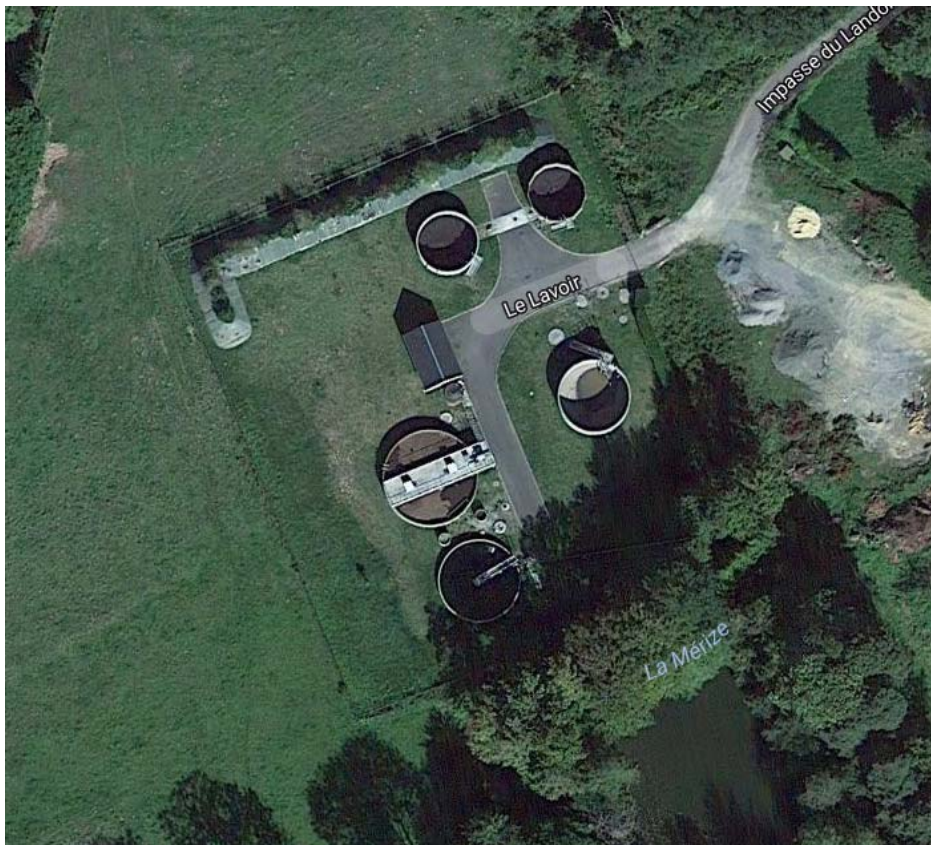
Vue aérienne de la station
