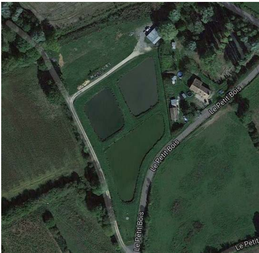
Vue aérienne de la station
