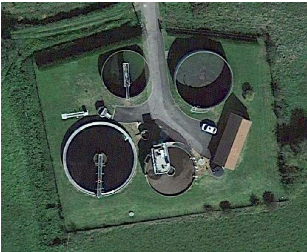
Vue aérienne de la station
