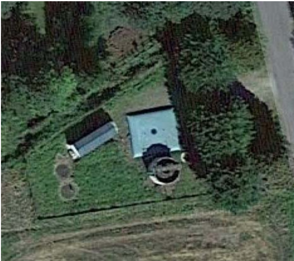
Vue aérienne de la station
