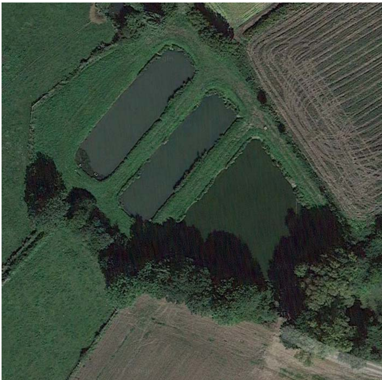
Vue aérienne de la station
