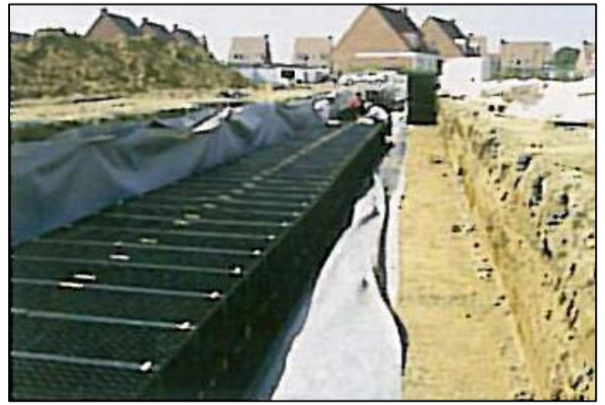
Photos 2 et 3 : Exemples de bassin tampon enterrés : « structure béton » à gauche et système de structures de stockage alvéolaires à droite
