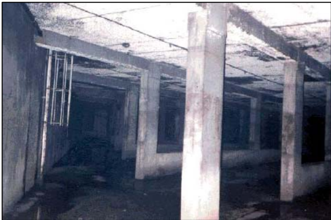
Photos 2 et 3 : Exemples de bassin tampon enterrés : « structure béton » à gauche et système de structures de stockage alvéolaires à droite
