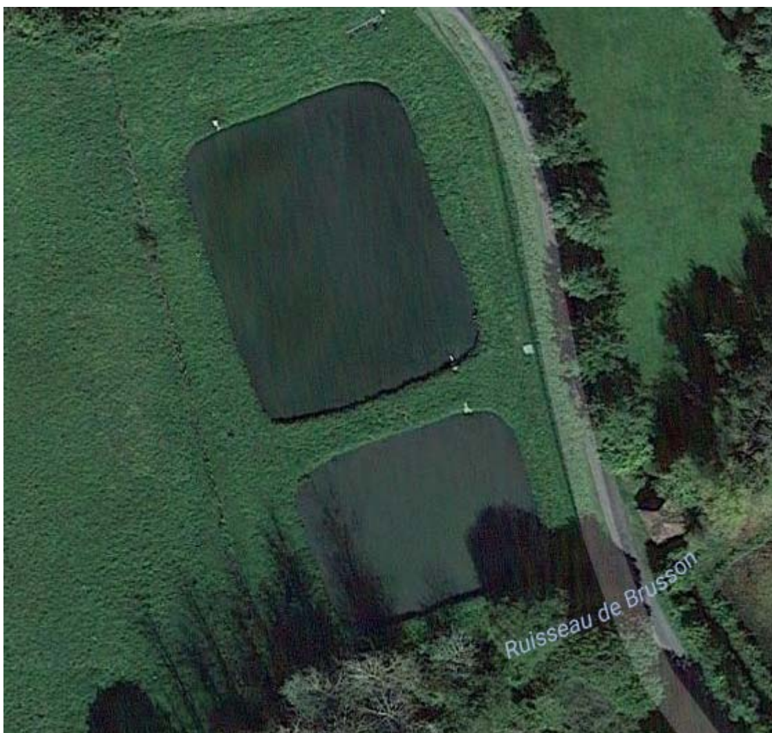
Vue aérienne de la station
