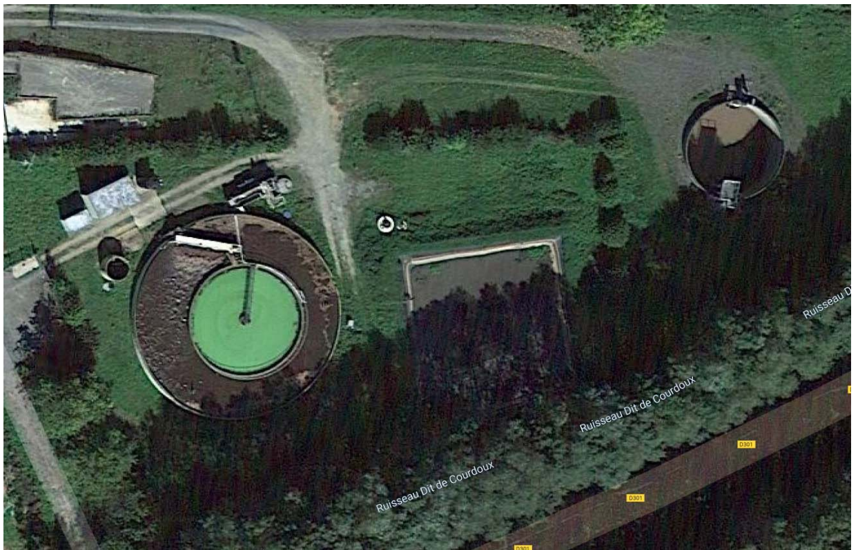
Vue aérienne de la station
