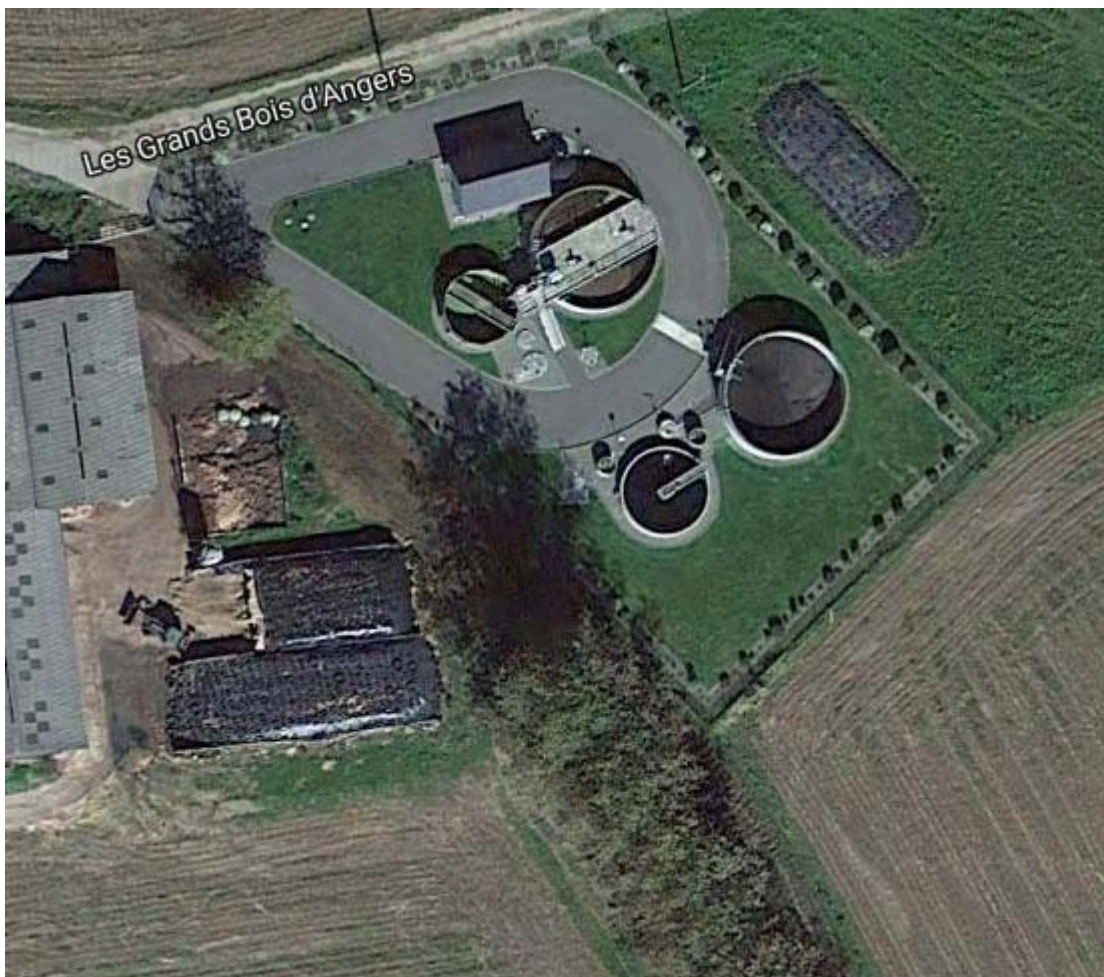
Vue aérienne de la station
