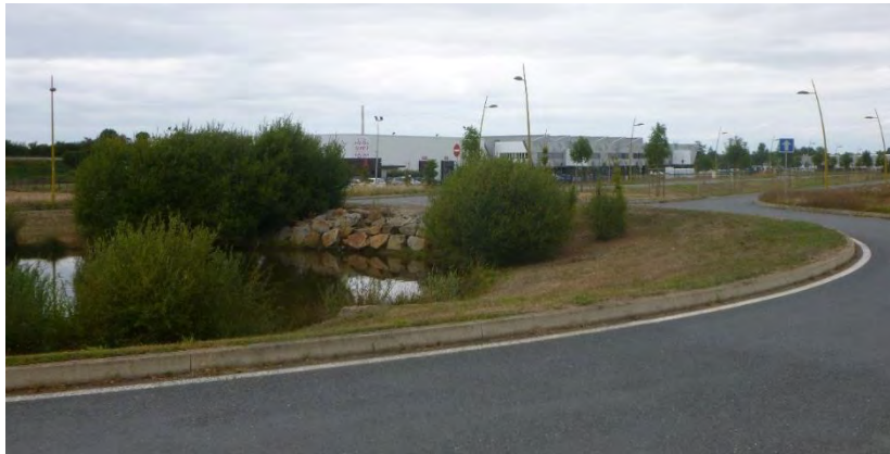
ZA du Point du Jour (Boufféré) : pour optimiser le foncier, la défense incendie est assurée via une réserve sur le giratoire dans la zone.
