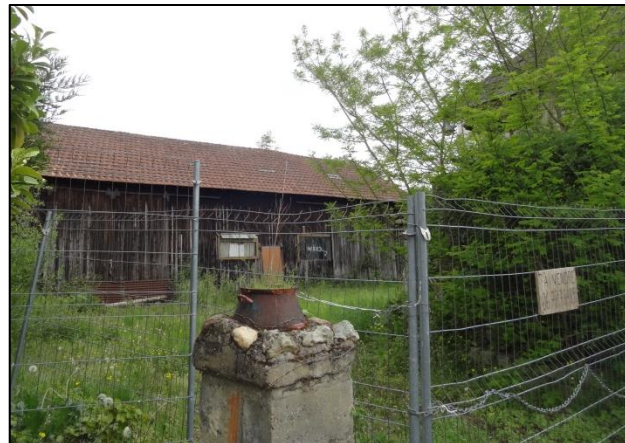
Bâti vacant à démolir pour accès à la future opération depuis la Grande Rue
