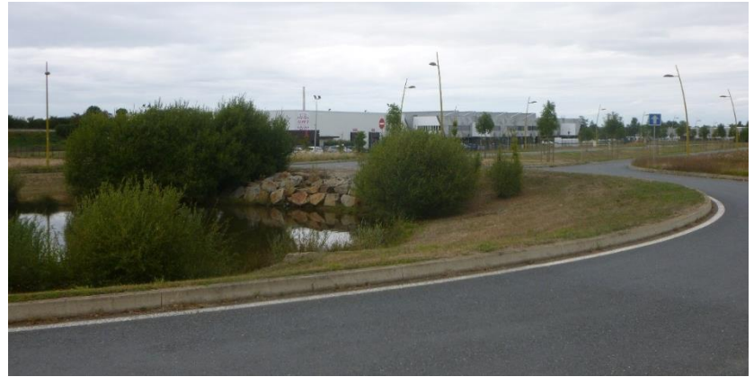
ZA du Point du Jour (Boufféré) : pour optimiser le foncier, la défense incendie est assurée via une réserve sur le giratoire dans la zone.
