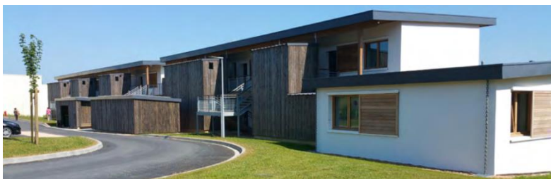
Logements intermédiaires et collectifs, Sarthe Habitat, Champ de Foire Montfort le Gesnois, 2015
