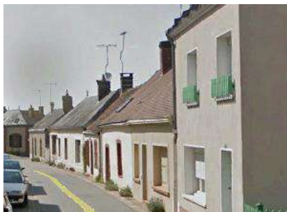
Des façades en alignement le long de voies étroites (rue principale)
