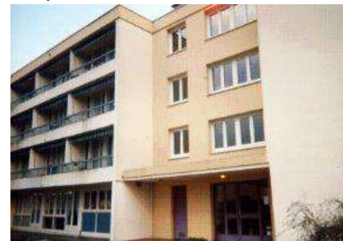
Foyer logement , logements CCAS Connerré 30 places
