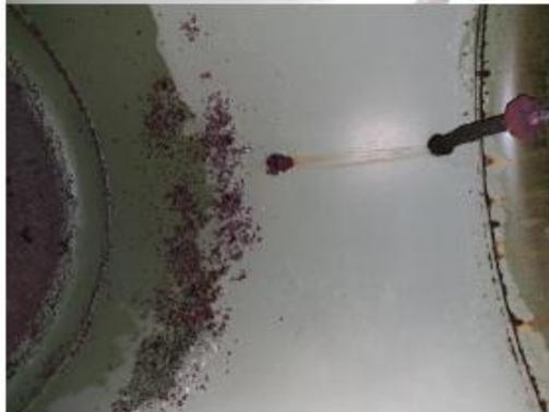
La photo met en évidence un état avancé de corrosion externe sur le ou les ballons d'ECS. On observe une dégradation visible à l'intérieur (rouille, cloques, oxydation)
