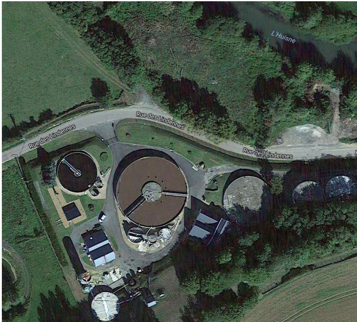
Vue aérienne de la station
