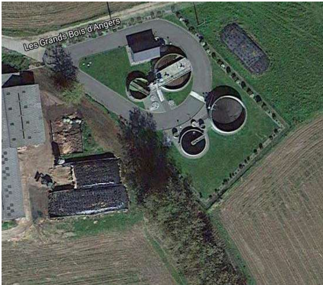
Vue aérienne de la station
