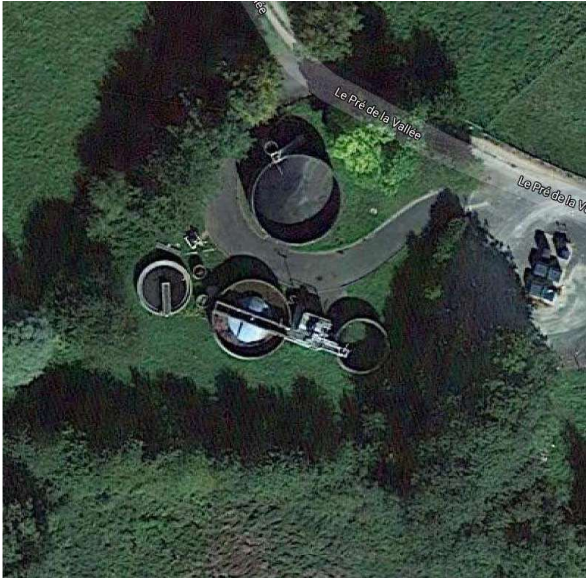
Vue aérienne de la station
