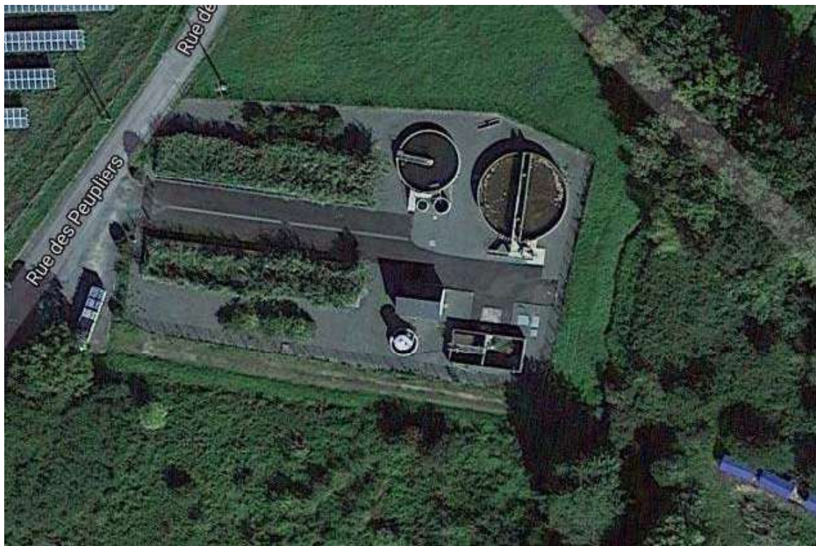
Vue aérienne de la station
