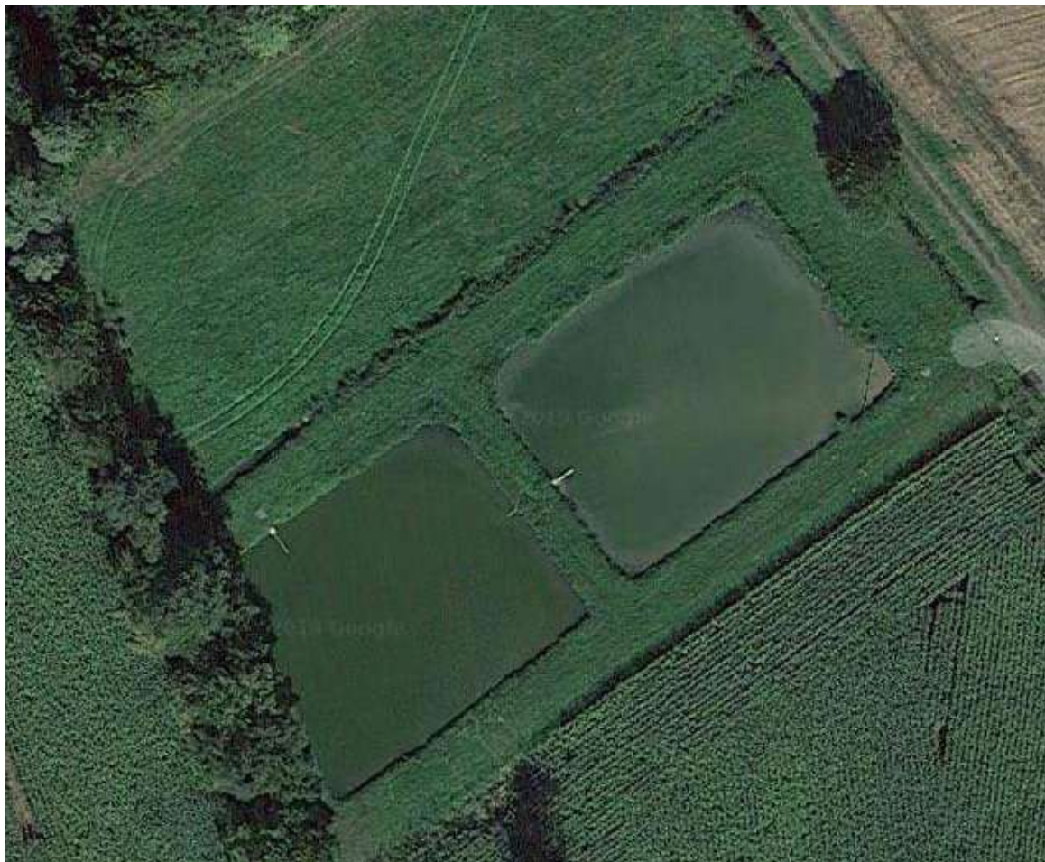
Vue aérienne de la station
