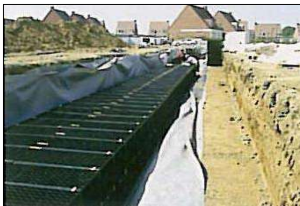
Photos 2 et 3 : Exemples de bassin tampon enterrés : « structure béton » à gauche et système de structures de stockage alvéolaires à droite
