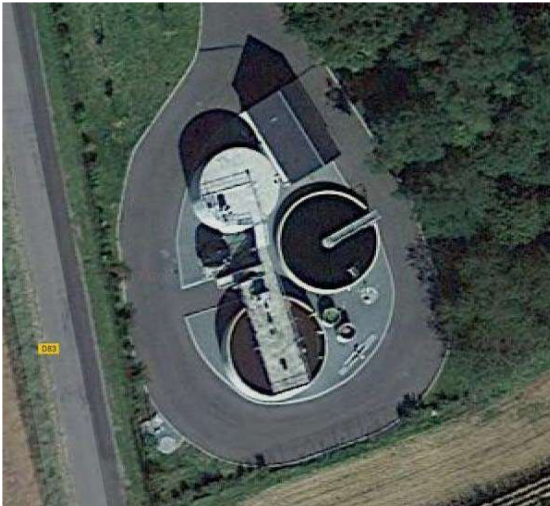
Vue aérienne de la station
