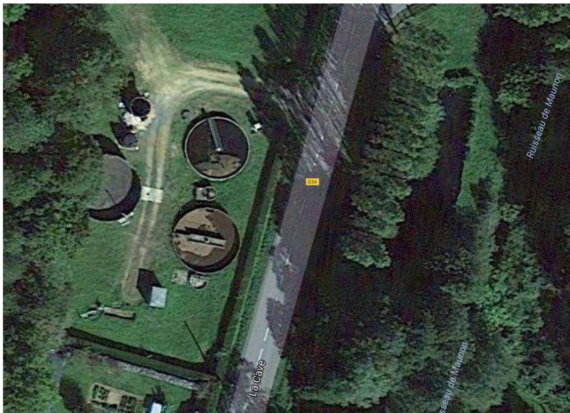
Vue aérienne de la station
