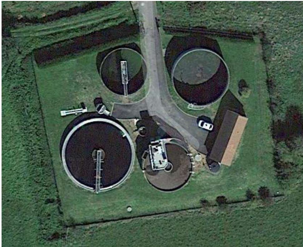
Vue aérienne de la station
