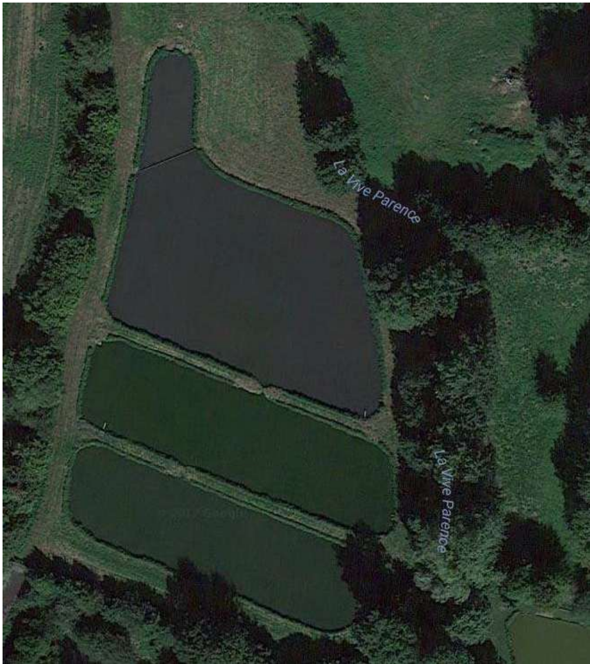
Vue aérienne de la station
