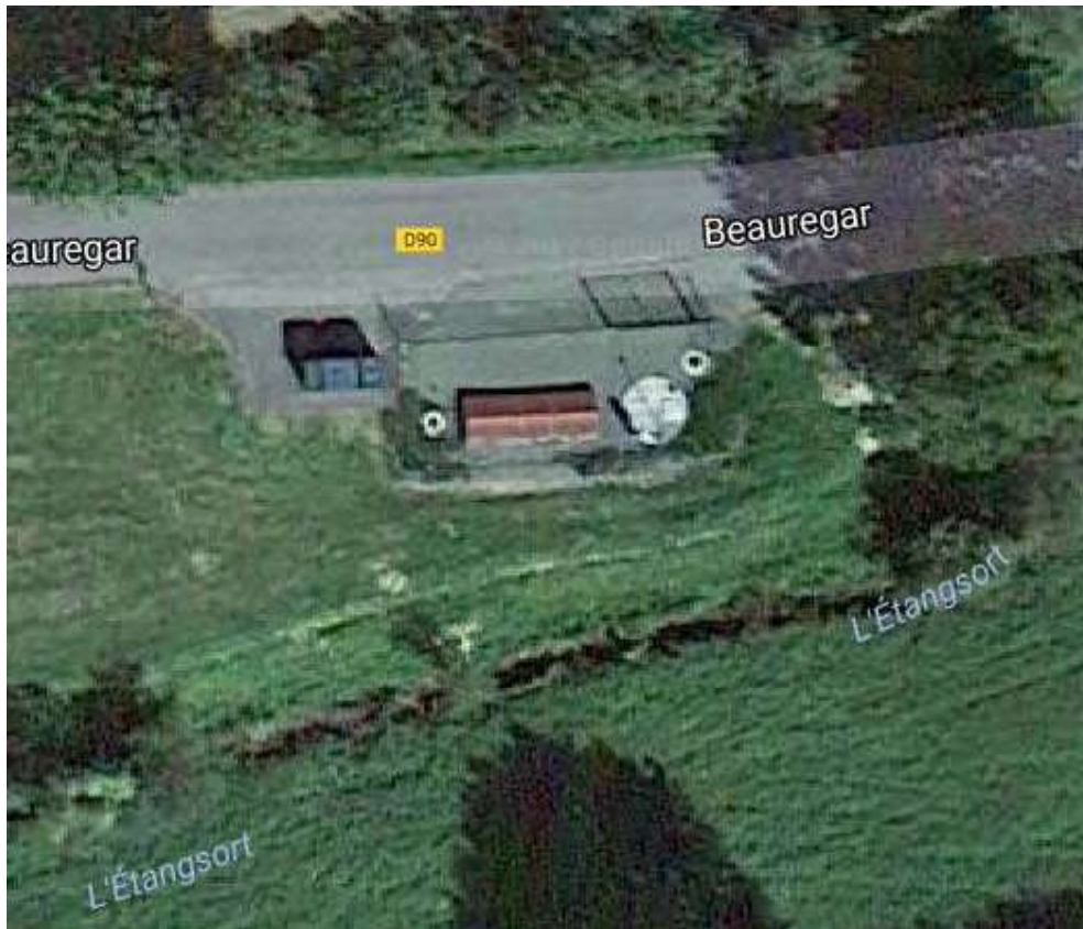
Vue aérienne de la station
