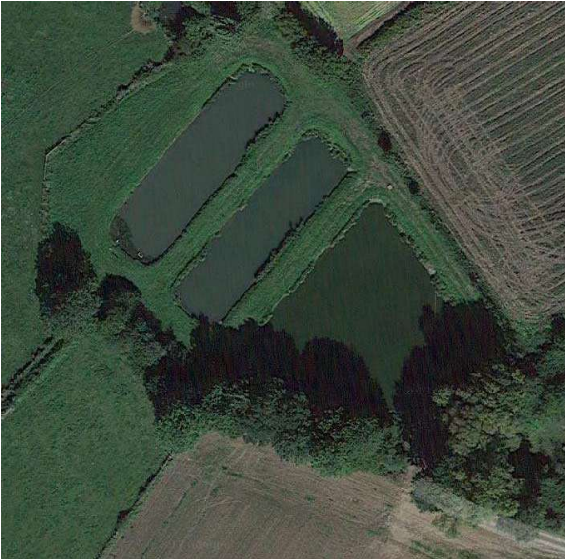
Vue aérienne de la station
