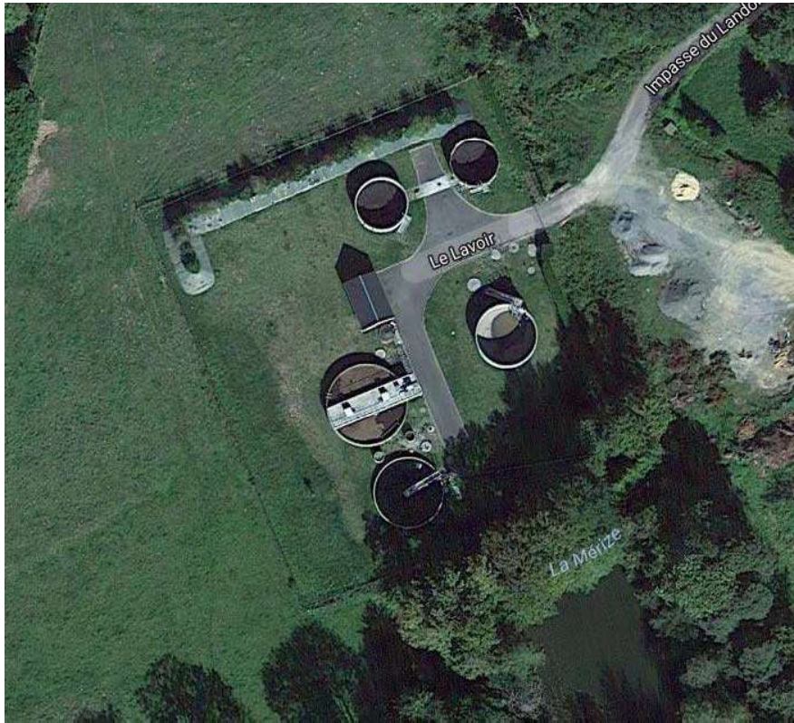
Vue aérienne de la station
