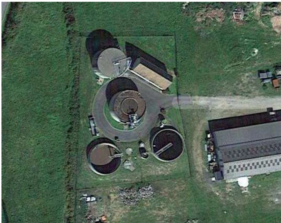
Vue aérienne de la station
